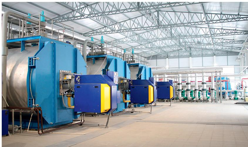
В 2015 году завершено техническое перевооружение газовой котельной филиала ОАО «КМПО» – 3МЗ установленной мощностью 16 МВт, которое позволило увеличить выработку тепловой энергии на **22%**; снизить годовой расход природного газа на **20%** и себестоимость выработки 1 Гкал тепловой энергии на **27%**.
