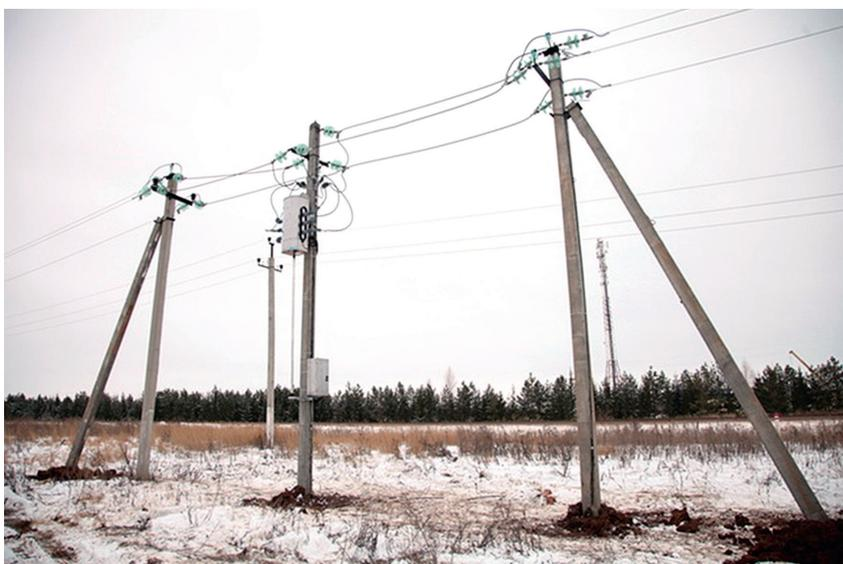
кончен монтаж трансформаторной подстанции 35/0,4 кВ. Это так называемый метод глубокого ввода. Эта технология широко распространена в Европе и является принципиально новой в обеспечении электроэнергией населенных пунктов Республики. Переход от напряжения 35 кВ сразу к классу 0,4 кВ (то есть минуя класс напряжения 10 кВ) позволяет умень-
