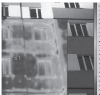
Рис. 2. Дом из газобетона с дополнительной отделкой утеплителем
