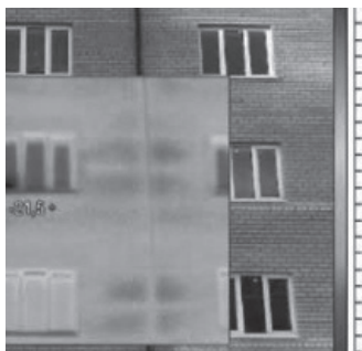
Рис. 3. Дом, построенный из блоков POROTHERM
